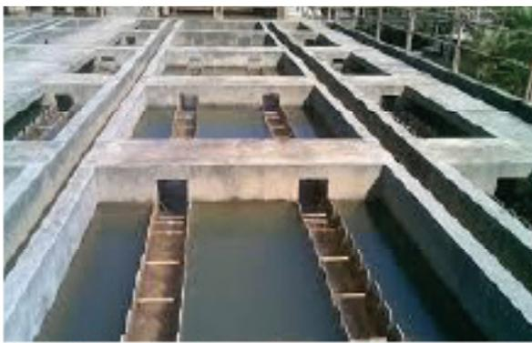
**Figura 1.** Tanque de decantação em estação de tratamento de água.
